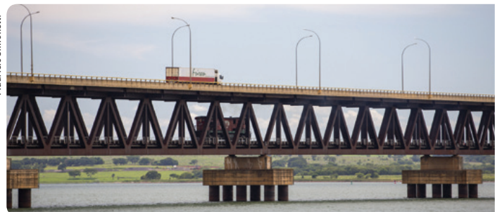
Caminhão e locomotiva trafegam em ponte rodoferroviária sobre Rio Paraná. Aparecida do Taboado, Mato Grosso do Sul, 2019.
